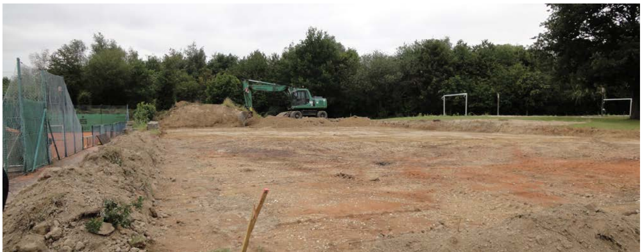
Beginn der Bauarbeiten zum 5. Tennisplatz im Juli 2011
