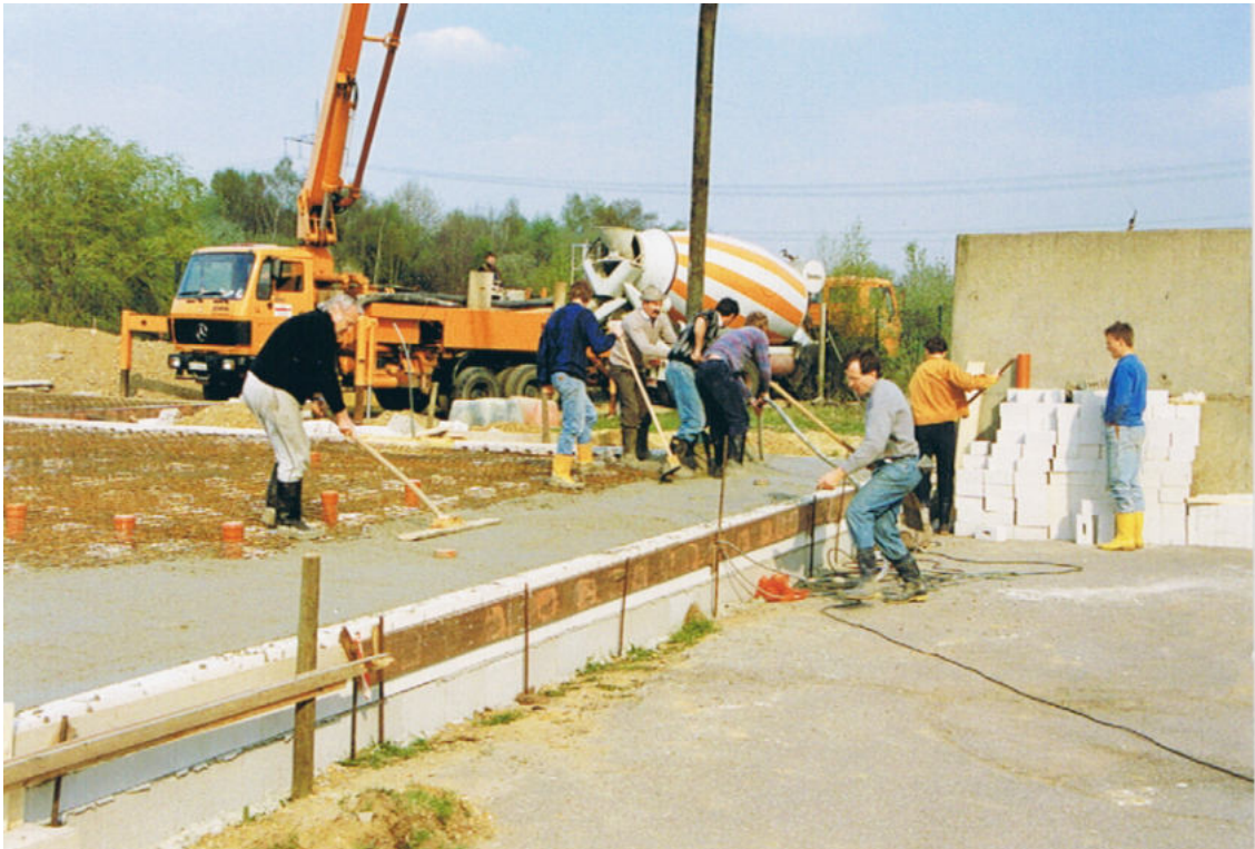
Die Bodenplatte des neuen Clubheims wird gegossen
